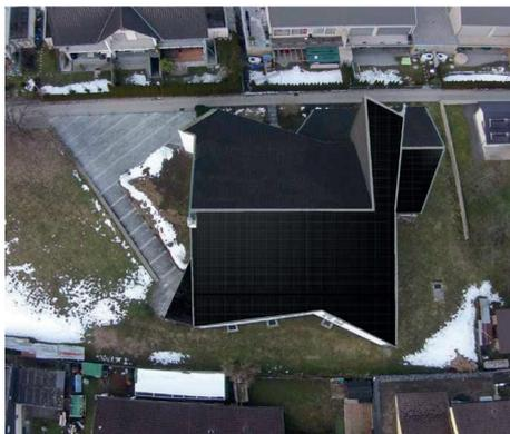
Das 56 Jahre alte Dach der Marienkirche muss ersetzt werden, ebenfalls die aus dem Jahr 1985 stammende Ölheizung. Der Stiftungsrat der Marienkirche Mollis hat sich entschieden, eine nachhaltige Lösung umzusetzen: die Süddächer der Kirche werden mit Photovoltaik Elementen gedeckt, die Ölheizung wird durch eine Wärmepumpenanlage ersetzt. Die Norddächer und der Kirchturm werden mit Eternit gedeckt. Die Erarbeitung des Konzeptes geschah in
